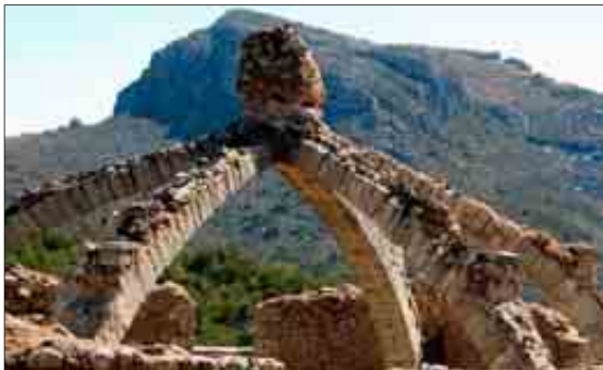
Cúpula arqueada de piedra de la Cava Gran de Agres./ E.M.
